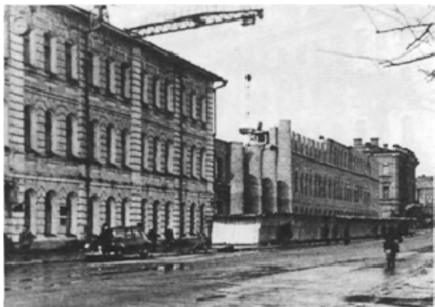
Реконструкция здания Томского электромеханического института инженеров железнодорожного транспорта, в котором впоследствии разместился ТИРиЭТ. 1958 год
