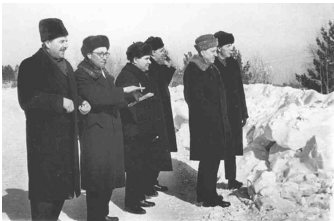
Здесь будет построен радиотехнический корпус ТИРиЭТа !
